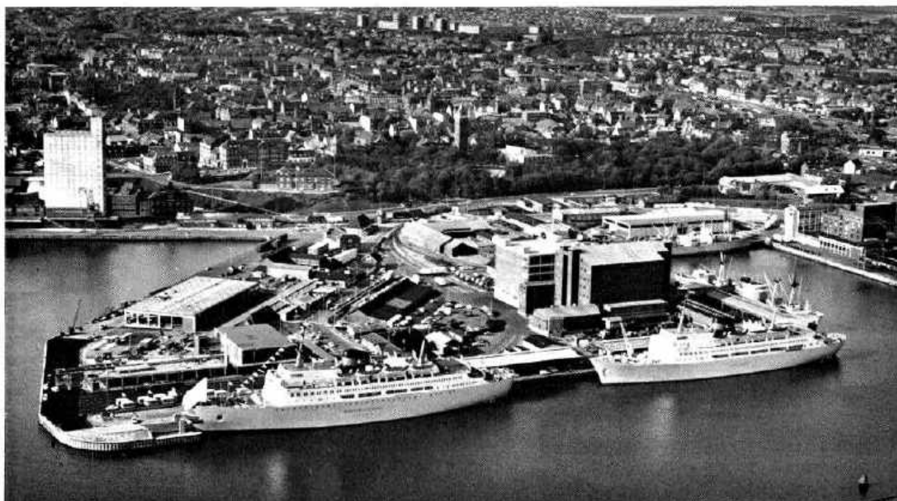
Et af Esbjergs frysehuse ved kajen ud for Englandsbådene. Til venstre DFDS-godsterminalen.
