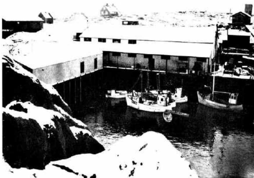
Anlægget i Napassok.
